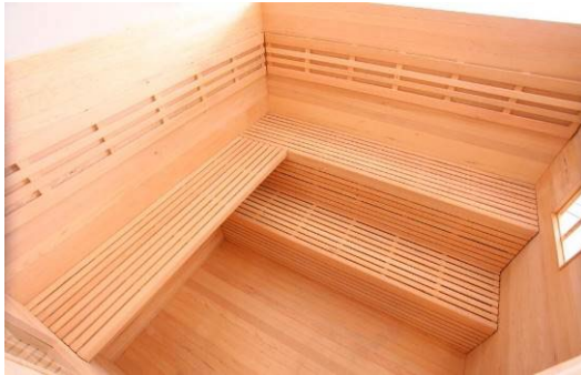
Figur A-6: Montering av 2 lager bänkskivor
